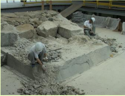
Thợ xây đục bỏ bê tông khỏi các khối đá gồc
