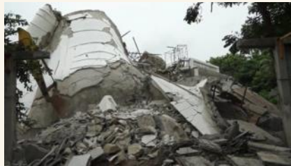
Tượng Phật lớn tại Chonburi bị sụp đổ do mưa to gió lớn Photo: Thai PBS
