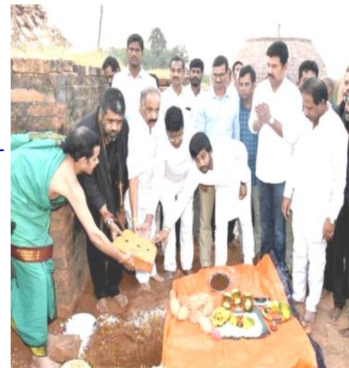
Lễ động thổ cho công việc sửa chữa bảo tháp Phật giáo tại thành phố Visakhapatnam, Ấn Độ Photo: The Hindu
